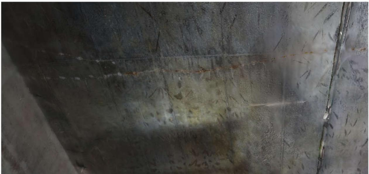
Abbildung 44: 3D-Modell Regenentlastungsbecken AWV Großsache Nord; Riss mit Korrosion (Klotz, 2020)
